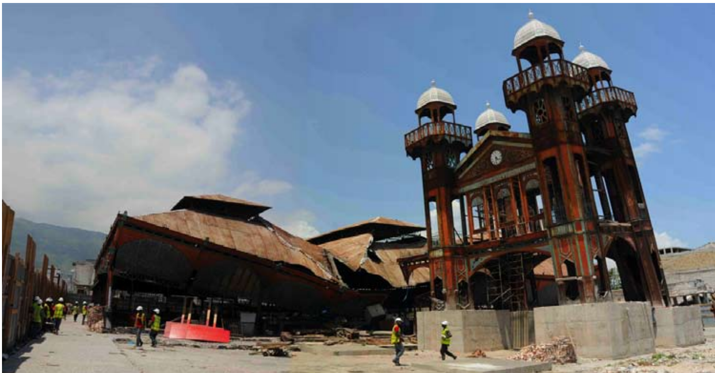
• Vue du chantier. Les plots en béton destinés à stabiliser le pavillon central seront démolis par la suite
