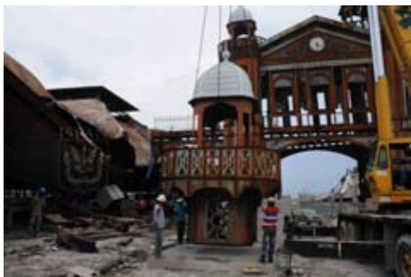
• Dépose d'une des tourelles du pavillon central
