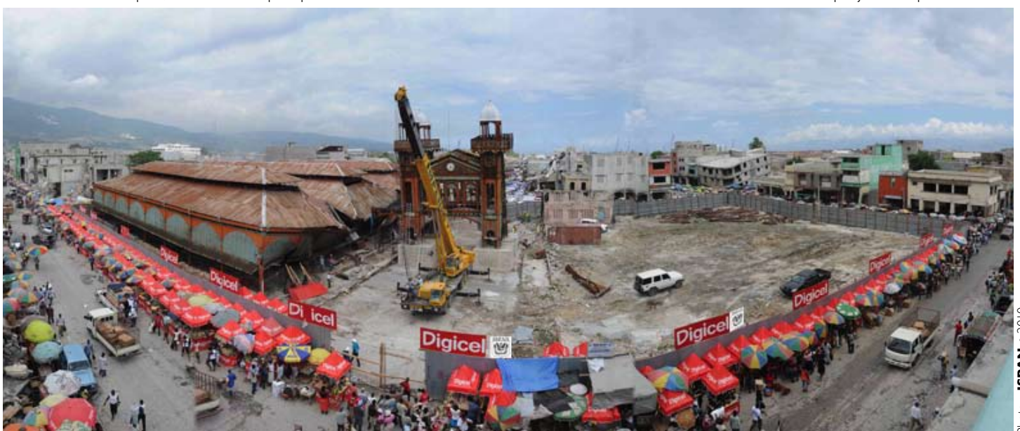
• Vues du chantier de restauration du marché Hyppolite
