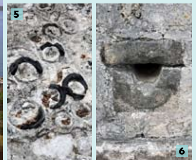
1. Plan de la Batterie de Grasse selon le projet de M. de Bellecombe, Gouverneur de Saint-Domingue • 2. Le mur de soutènement auxquels étaient adossés les bâtiments de services • Vue du parapet donnant sur le rivage • 4. Vue générale des ruines et, au fond, la pointe de la Presqu'île • 5. Les tessons de bouteilles fixés à l'arase des murs de soutènement • 6. Barbacane en pierre de taille de la muraille des remparts
