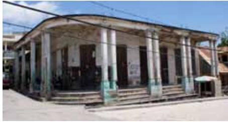
• Bâtiment avec galerie à ossature en béton (angle des rues Abbé-Huet et Brice-Ainé)
